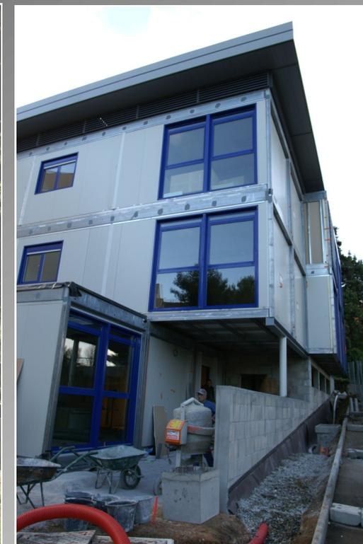
**Bâtiment métallique modulaire préfabriqué sur 3 niveaux avec ascenseur.**
