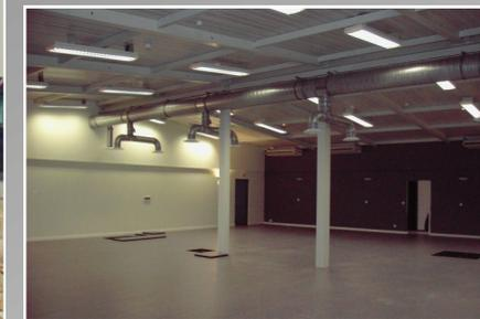
*Bâtiment structure modulaire métal + charpente métal + plancher béton*
